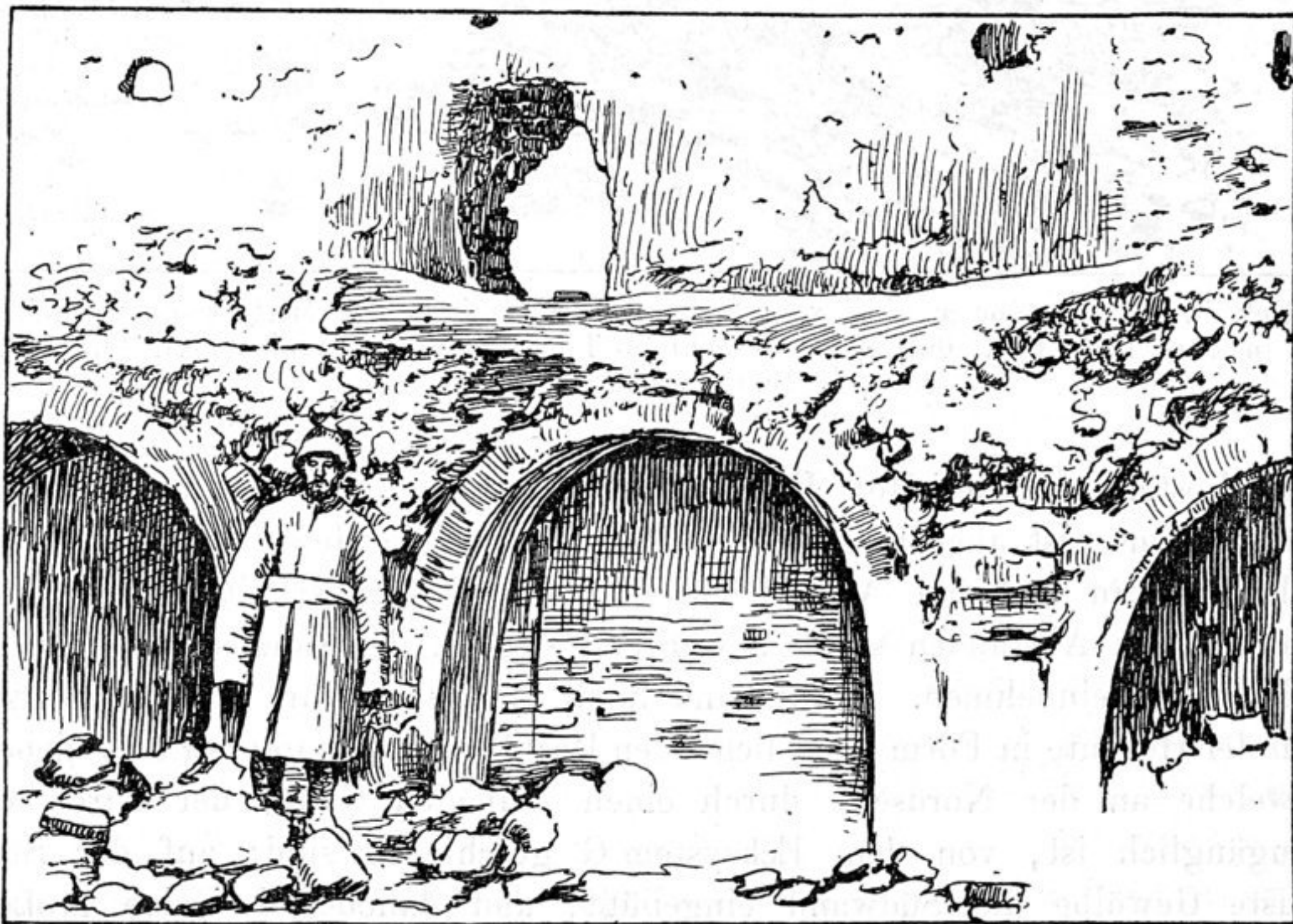
* Fig. 68. Gewölbereste von a' a' im Inneren der südlichen Außenmauer des Klosters \beta , vom Innenhofe aus gesehen. Der Schutt liegt hier sehr hoch, so daß die Gewölbe dadurch sehr niedrig scheinen. Darüber sieht man die Reste des ersten Stockwerkes der Südmauer. Die Lücke in der oberen Wand ist kein Fenster, sondern eine Bresche, gelegt, um von außen hereinklettern zu können.
