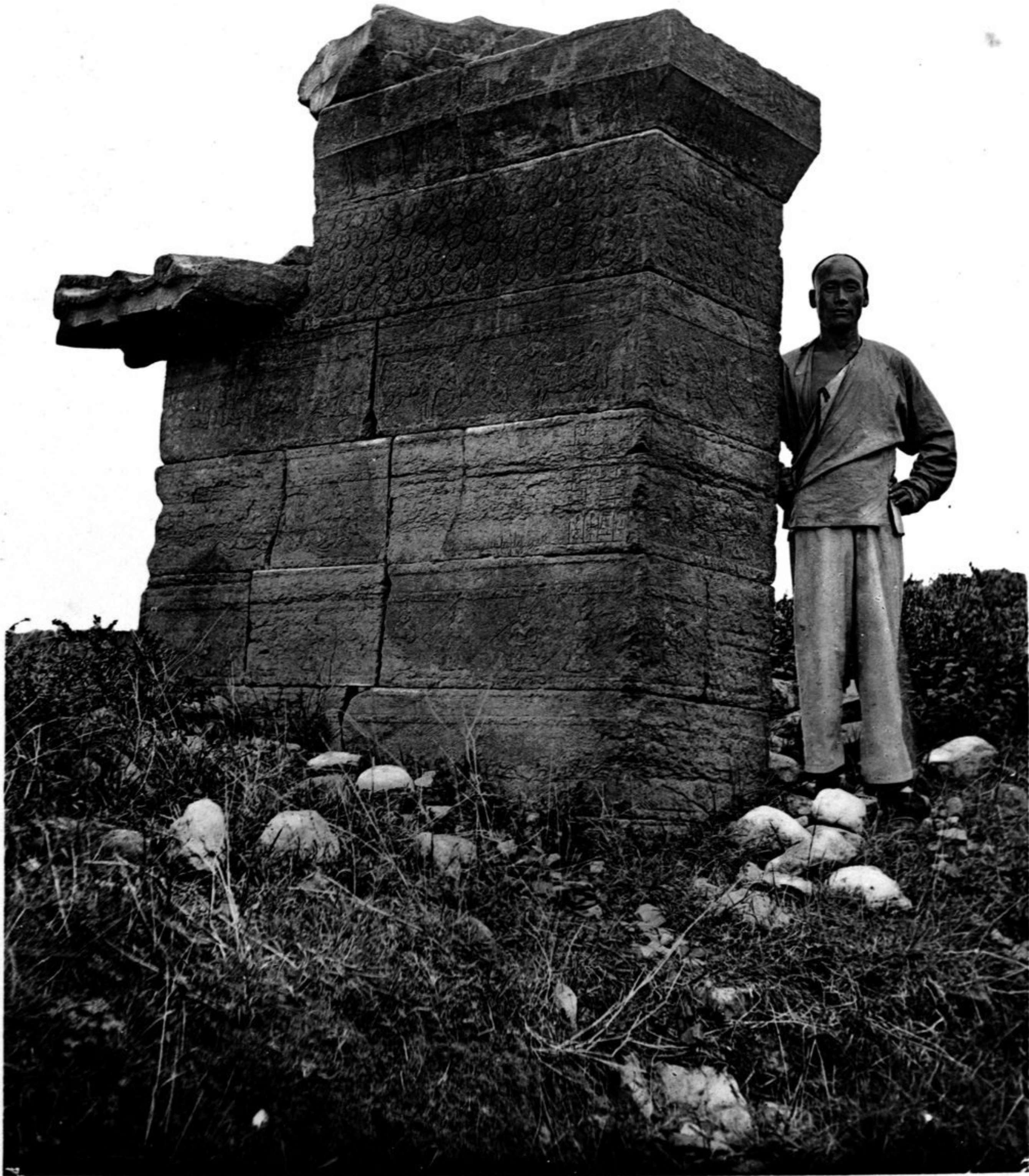
PILIERS DU CHAO CHE N° 28. — Face Nord du Pilier de l'Est
