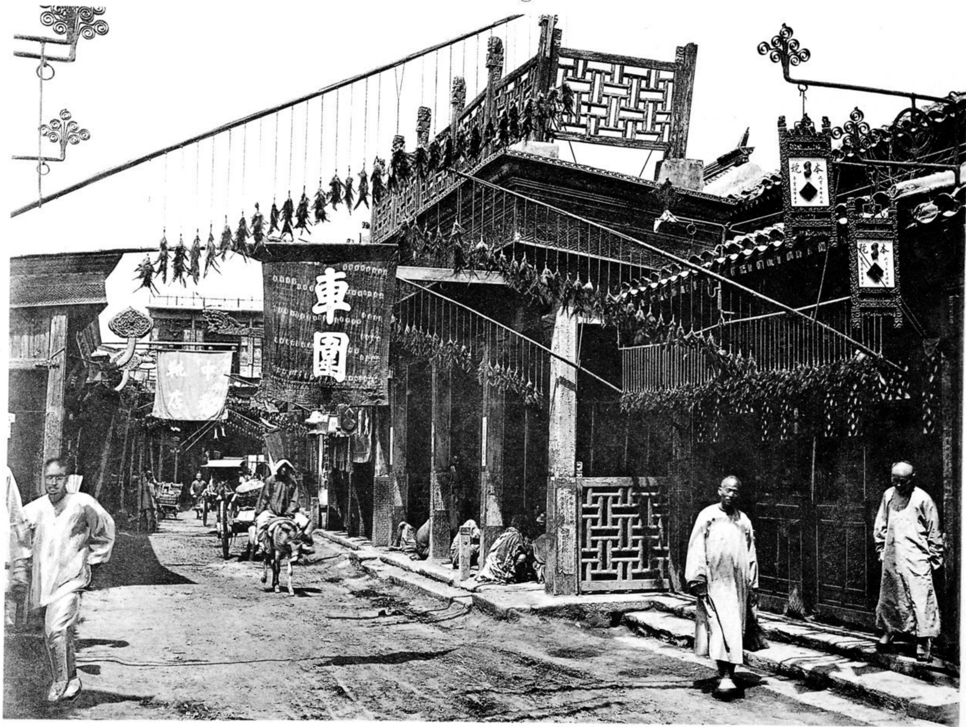
Eine Seitenstrasse der Kaiserstrasse.
