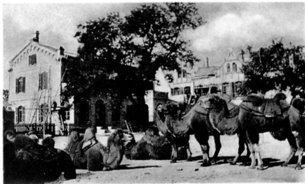
Ausbesserung der durch die Beschiessung beschädigten Gebäude (Kameele Kalk bringend).
