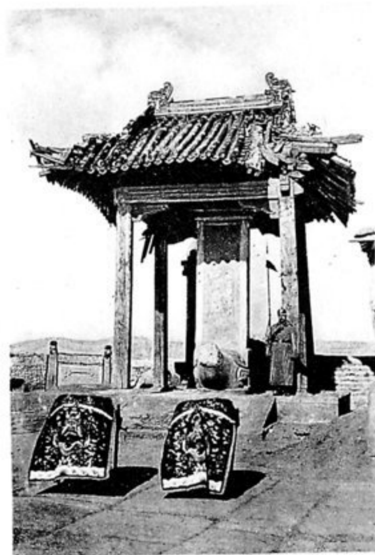
Zerfallener Pavillon an der Marco-Polo Brücke unter deutschem Schutz.
