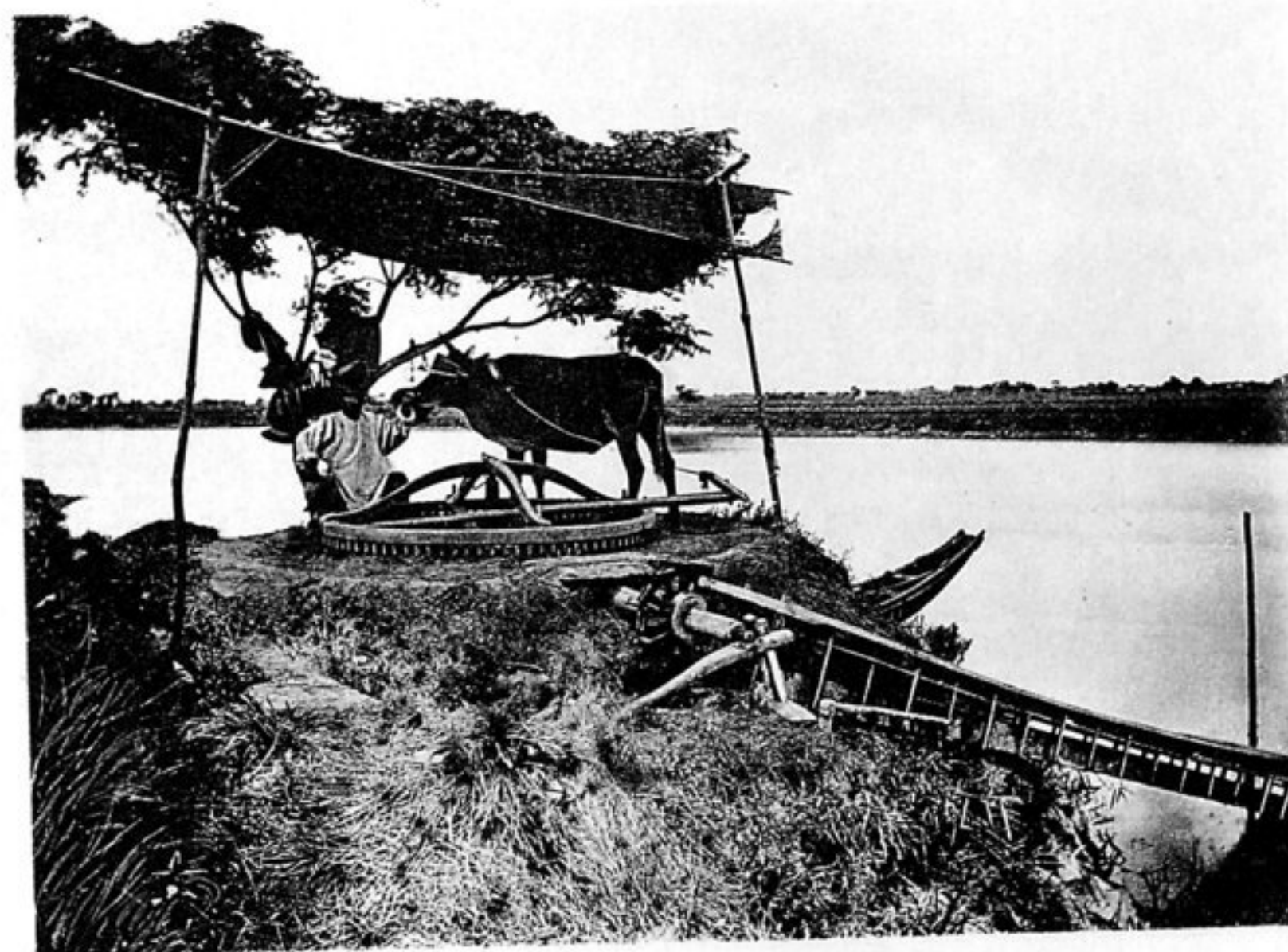
Bewässerungs-Anlage am Westfluss bei Canton.
