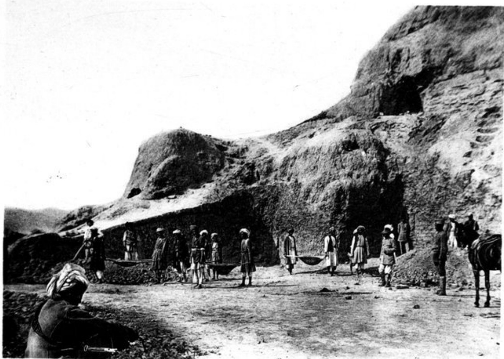
a) COIN NORD DE L'ESCALIER EST.
