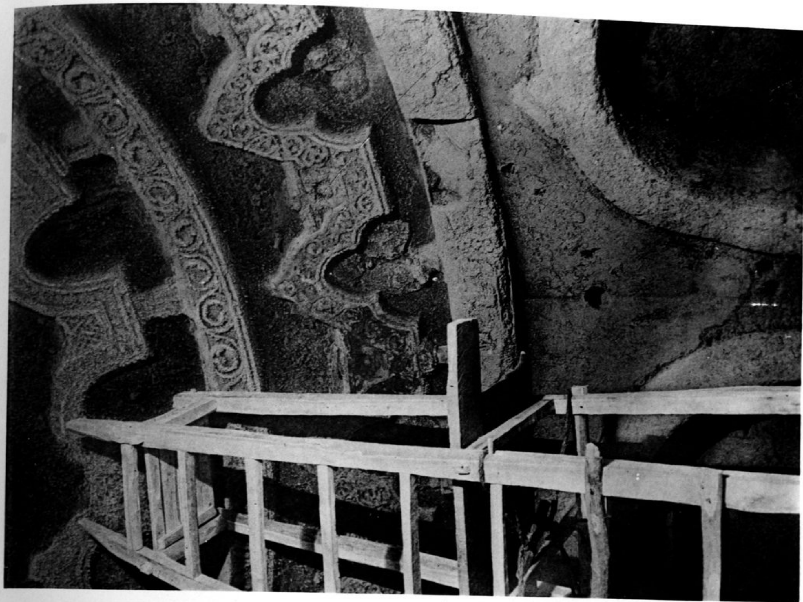
FIG. 31. — GROTTA XI. TOUR ÉDIFIÉE POUR FACILITER LE NETTOYAGE, L'EXAMEN ET LE RELEVÉ PHOTOGRAPHIQUE DE LA DÉCORATION DE LA GROTTA.
