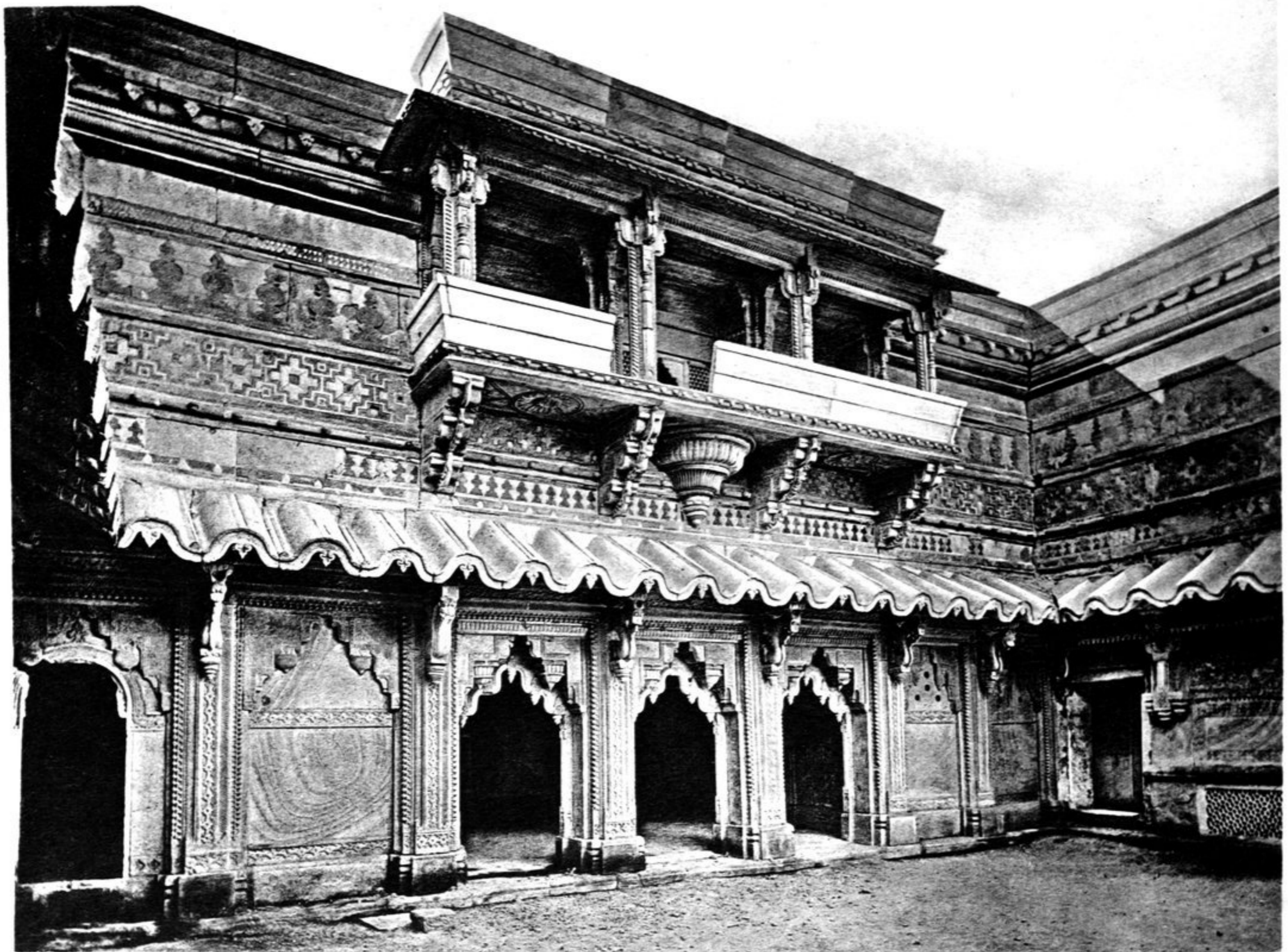
Westseite des Hofes B.
