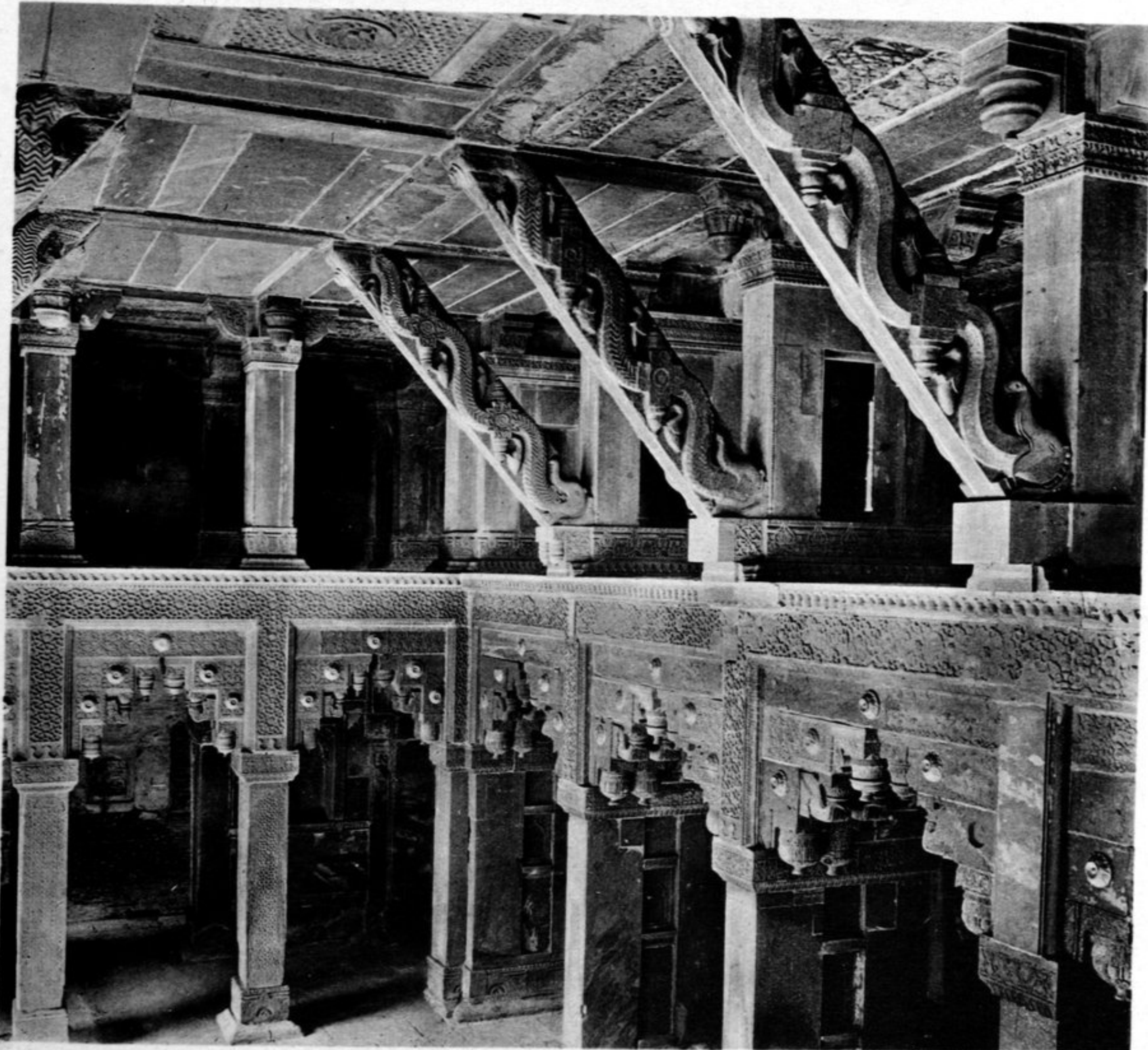
Saal 3 aus der Südostecke der Empore gesehen.
