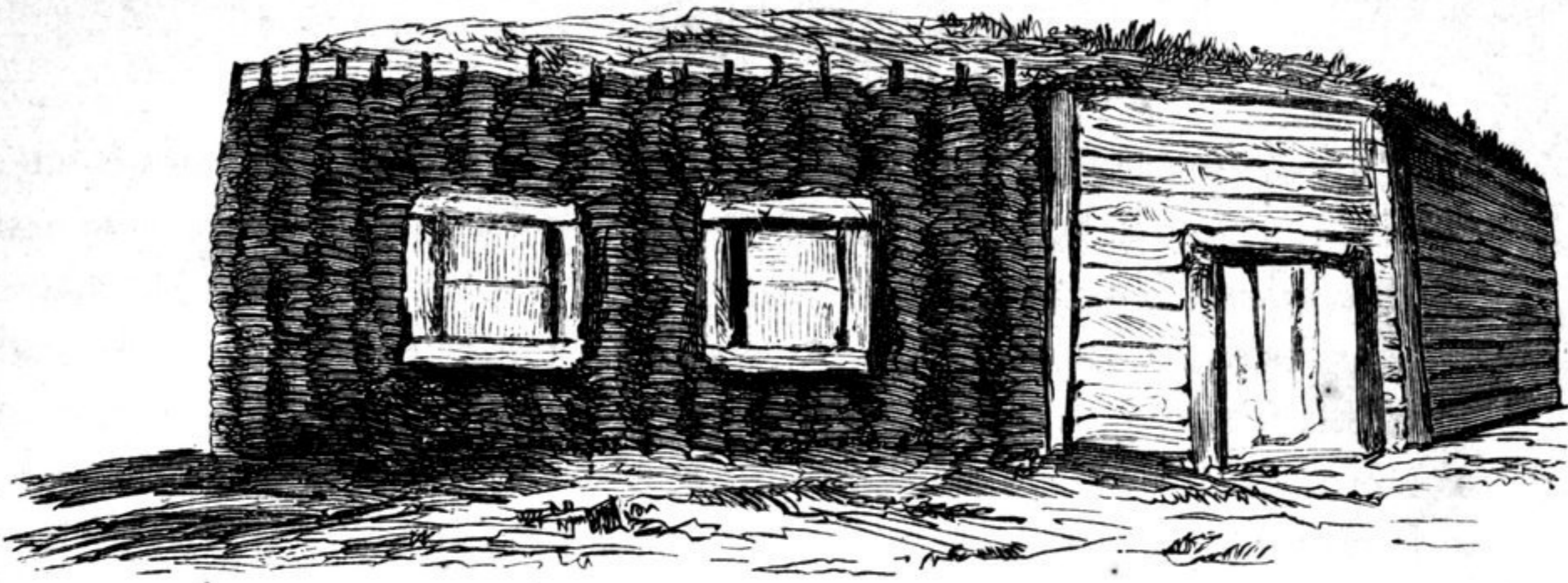
Teleutisches Haus aus Flechtwerk und Brettern.
