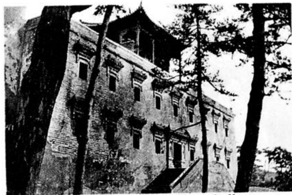
Massive Basis der Haupthalle.
