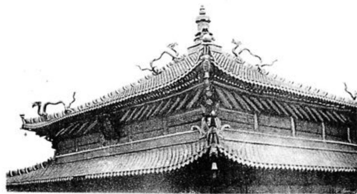
Dach der Haupthalle aus Goldbronze.
